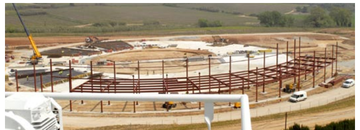
Der Wissenschaftspark in Cerdanyola im Bau Quelle: Carlos Dapena, Cons CD
