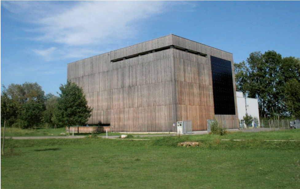
Biomasse-Blockheizkraftwerk in Ostfildern.
