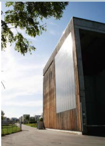
Holzheizkraftwerk im Scharnhäuser Park
